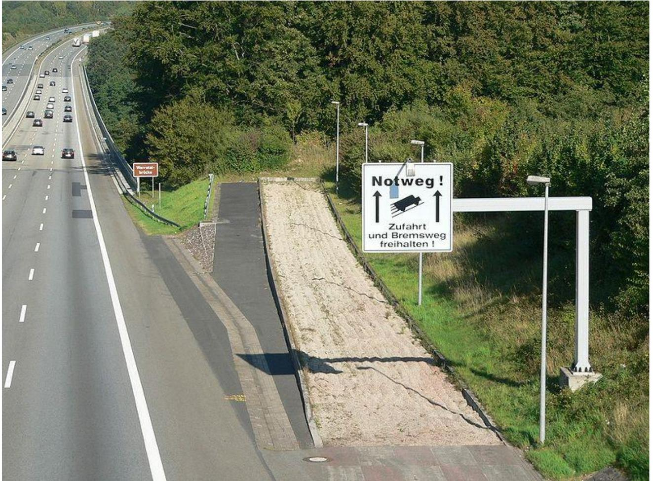
runaway-lane auf der A7 (Werratalbrücke)
